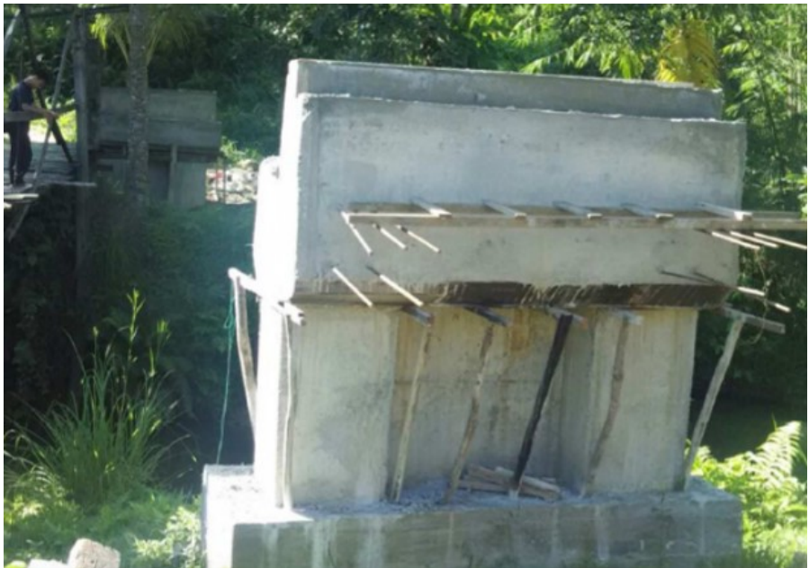
Gambar 3. Kondisi Akhir Pekerjaan Tahap-I. (Sumber: Ophiyandri, Laporan Kegiatan Tahap-I, 2015)
