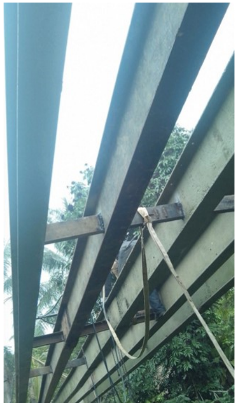
Gambar 9. Perkuatan Berupa Gelagar Melintang
