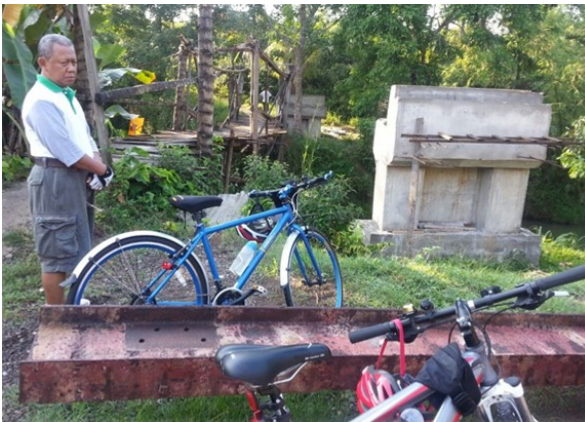
Gambar 5. Kondisi Awal Tahap II Jembatan Sungkai
