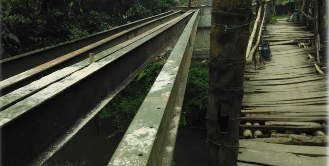
Gambar 8. Baja Profil Diletakkan Pada Kedua Abutment
