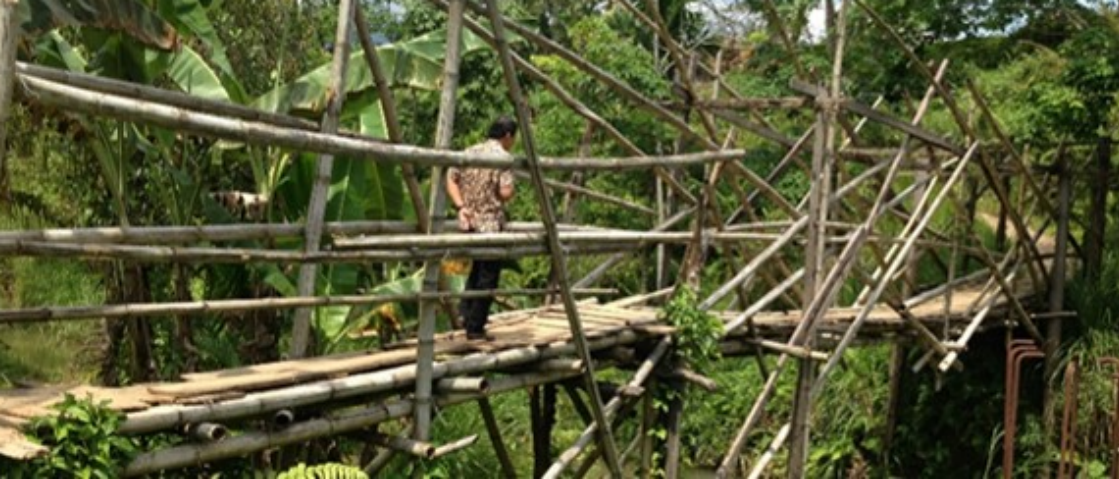
Gambar 1. Kondisi awal jembatan penghubung
